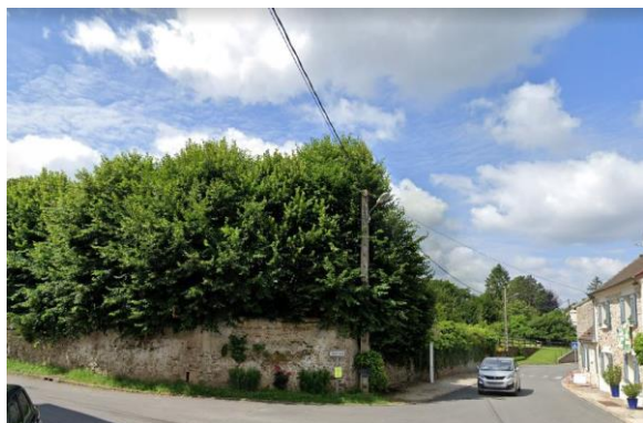
Mur angle rue des Vignes, rue de Verdun
