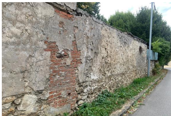
Mur rue des Vignes
