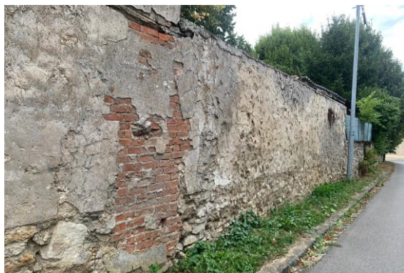
Mur rue des Vignes
